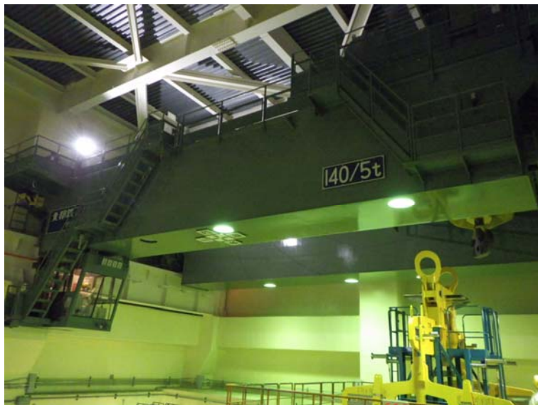
共用プールキャスク搬出入エリア天井クレーン 共用プール建屋へ搬入したキャスクを搬送台車へ乗せるために、1階に設置されてある天井クレーン
