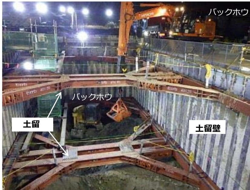
写真① 立坑掘削状況（下流水槽）
