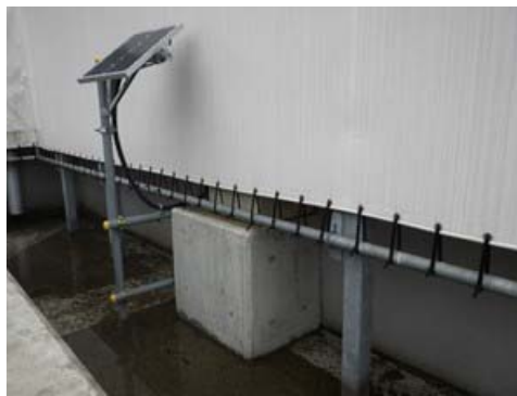
内堰外側に設置時
