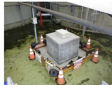
内堰基礎部に設置後
