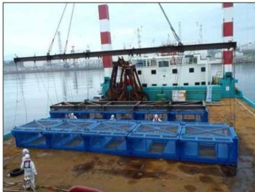
ブロックフェンス設置時の様子
