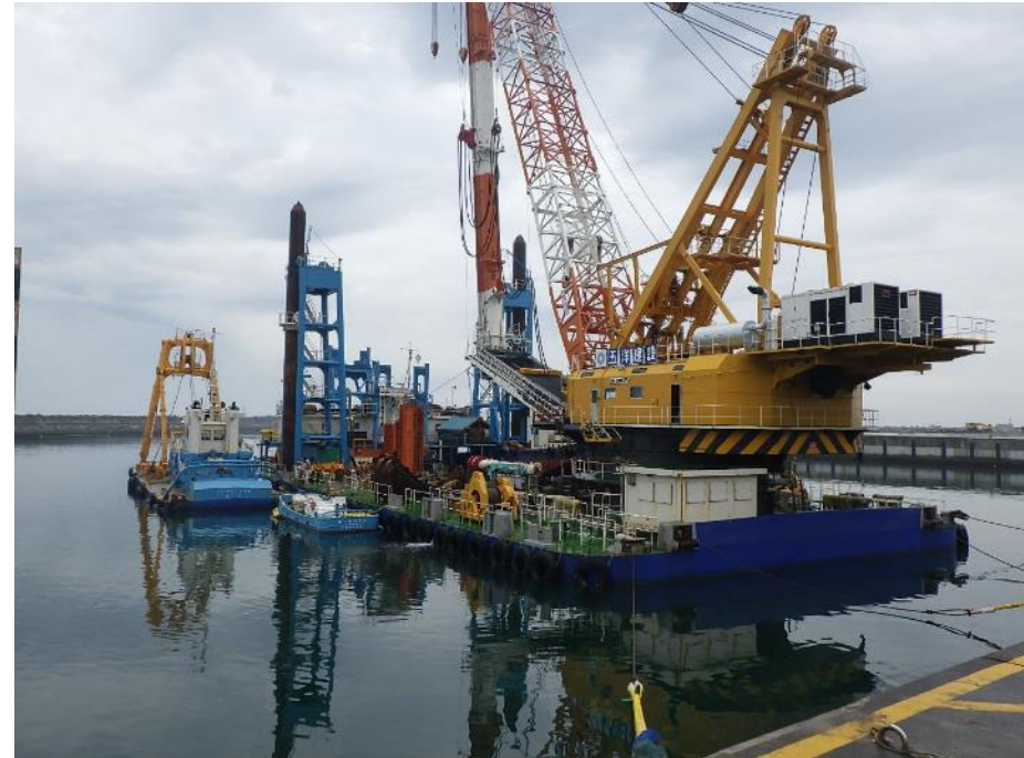
図2.作業船(物揚場での係留状況)
