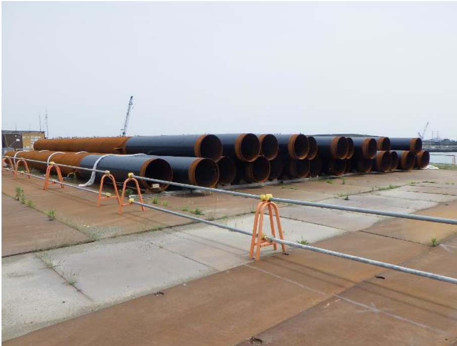
図1.鋼管杭(構内での仮置き状況)
