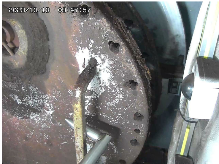
図3.X-6ペネハッチの開放作業中の状況
