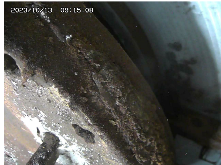
図2.X-6ペネハッチの開放前の状況
