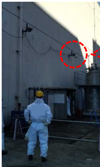
【現場状況（建屋外観）】
