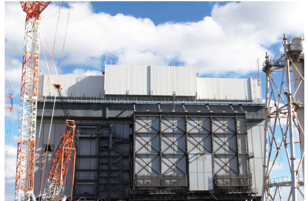
可動屋根設置し、屋根が全閉した時の様子（西より撮影） （撮影日:2026年1月16日）
