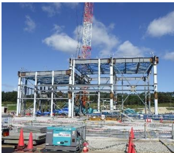
減容処理設備の建設状況 (2021年10月撮影)
