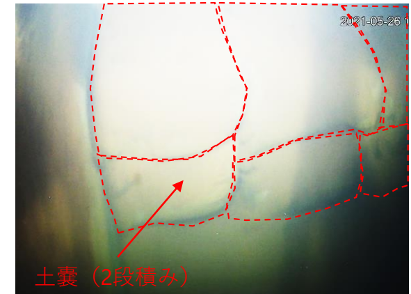
高温焼却炉建屋地下階で確認されたゼオライト土嚢
