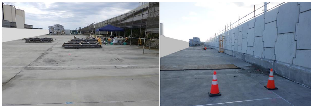
日本海溝津波防潮堤設置工事 (左：施工前、右：施工後)
