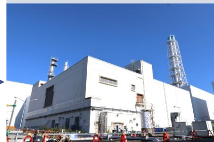
高温焼却炉建屋
