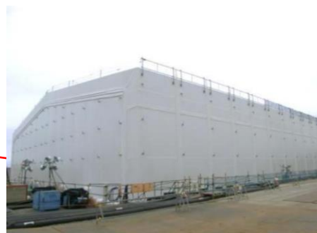
多核種除去設備（ALPS）
