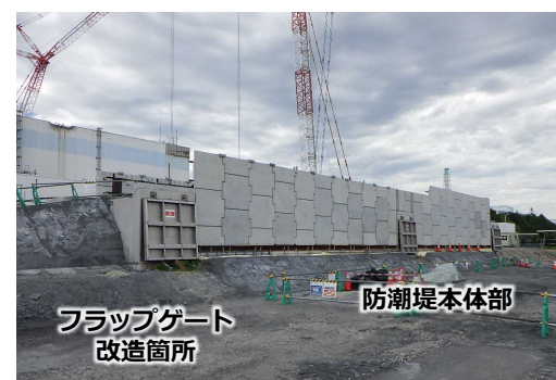
【写真②】北側防潮堤本体構築中（2022.8）
