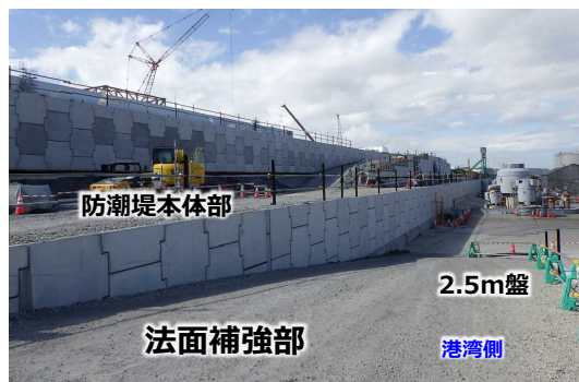
【写真①】防潮堤本体施工中（2022.9）
