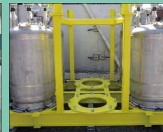
協力企業棟 安全通路屋根(長さ約100m) 使用済吸着塔の保管架台
