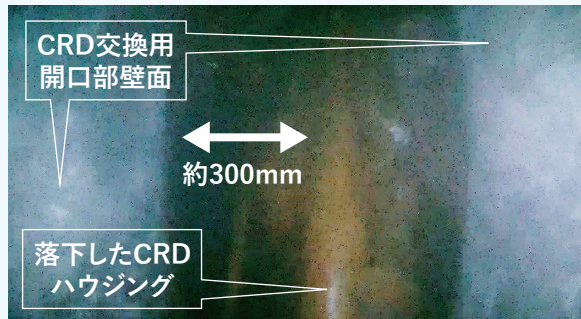
写真1. CRD交換用開口の状況(ちらつき補正後)
