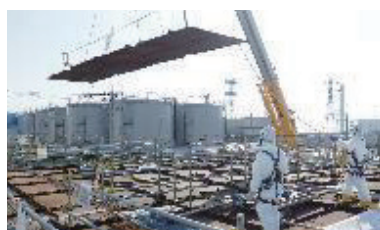
ノッチタンク蓋の開放 (参考:蓋開閉時の写真)
