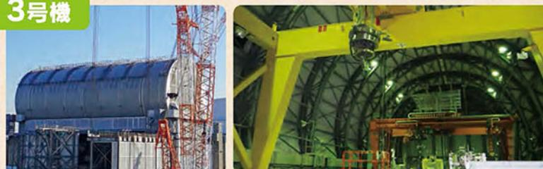
使用済燃料プール内からの燃料取り出しに向け、燃料取扱設備の設置が完了しています。今後は、模擬燃料・輸送容器を用いた操作訓練などを行い、安全を最優先に作業を進めています。
