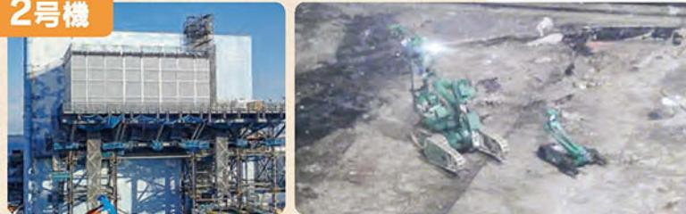
オペレーティングフロア\*内の残置物を遠隔操作が可能な重機やロボットで移動させる作業を行った後、空間線量の測定や汚染状況の調査などを行いました。今後は、調査結果をもとに使用済燃料プール内からの燃料取り出しに向け、遮へい設計や放射性物質の飛散防止対策などを検討していきます。
