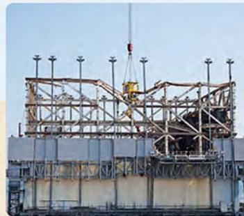
使用済燃料プールからの燃料の取り出しに向けて、オペレーティングフロア\*のがれき撤去作業を行っています。今後は、開口部を養生し、使用済燃料プール周辺の小がれき撤去などを進めていきます。がれき撤去後は、燃料取り出しカバーや取り出し用設備の設置などの準備を進めています。
