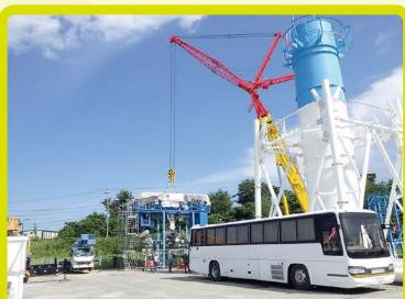
◀再現された排気筒上部と遠隔操作室が入るバス。バスはこのまま発電所構内に移動し、実際に操作室として使用されました。
