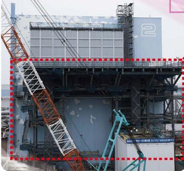
水素爆発を起こさなかった2号機は、原子炉建屋を残したまま使用済燃料プールからの燃料取り出しを実施します。作業時に外部へ放射性物質が飛散しないよう建屋南側に燃料取り出し用構台を設置し、原子炉建屋に作業口を開け、そこから取り出し機器を用いて横から取り出します。2024~2026年度の取り出し開始に向け、現在は、構台を設置するための路盤整備を行っています。
