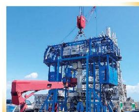
◆巨大な解体装置は、高さ約120mの排気筒の上部約60mを解体するためを使われたもの。この装置を排気筒の上部に設置し、地元企業株式会社エイブルさまにより遠隔操作で行われました。
