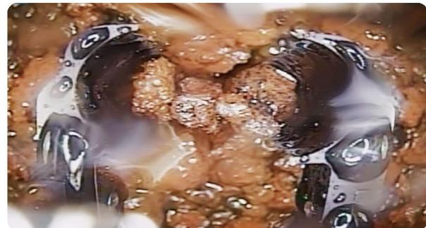
▲水中ロボットで撮影した小石状の堆積物
