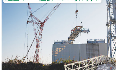
建屋カバー解体工事 壁パネル取り外し (18枚目)
