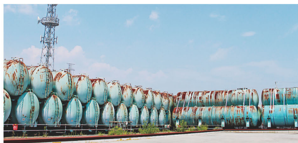
燃料デブリ取り出し関連施設等を建設する敷地を確保するためタンクを減らすことが、廃炉へとつながる
