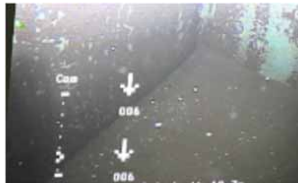
【Bottom of the cask pit】
