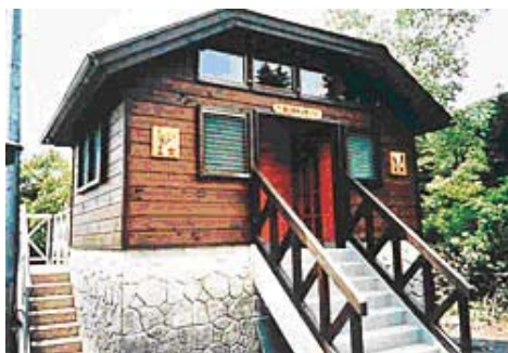
<Fujimitoge public toilet>
