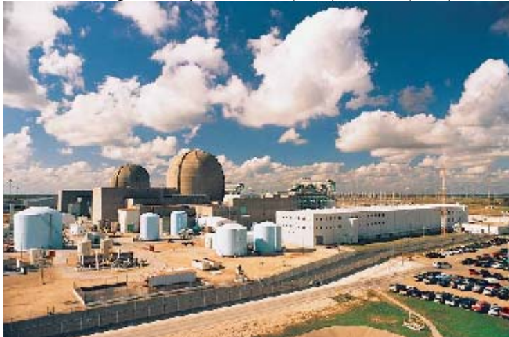
(Photo courtesy: STPNOC)
