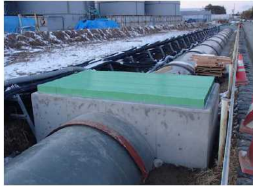
③FRP管施工完了（撮影日H26.2.7）
