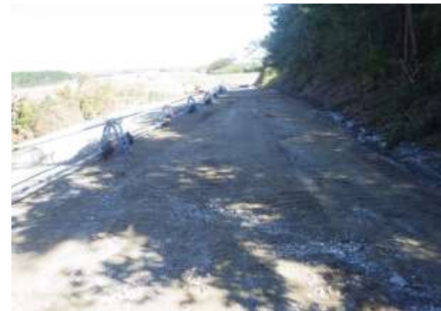
【After emergency repairs】
