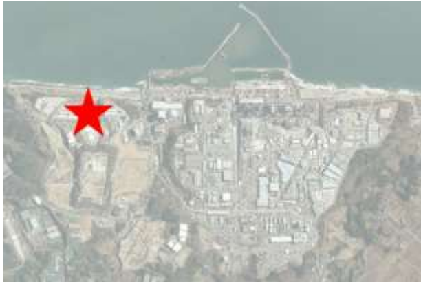
【Location of collapse】
