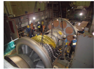
新しいガスタービン設備の組立状況
