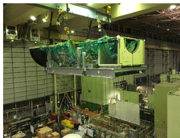
新しいガスタービン車室の吊り込み作業
