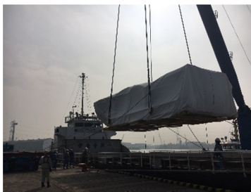
新しいガスタービン車室の荷揚げ作業
