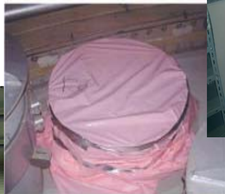
ベント管開口部の養生
