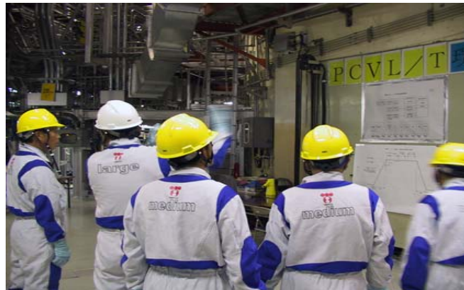
福島第一 1号機原子炉格納容器漏えい率検査(H16.5.27)
