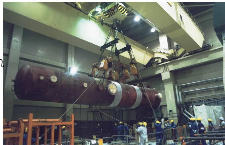
給水加熱器取替工事
