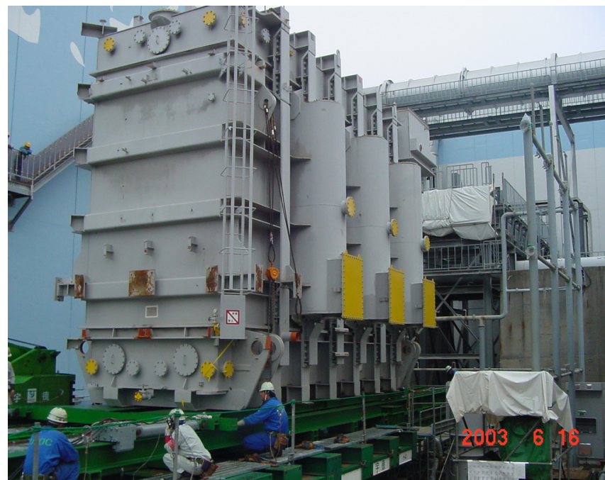
主要変圧器取替工事
