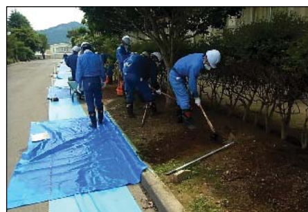
簡易除染作業状況
