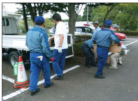
プランター設置（広野町役場） [H25. 7. 31撮影]
