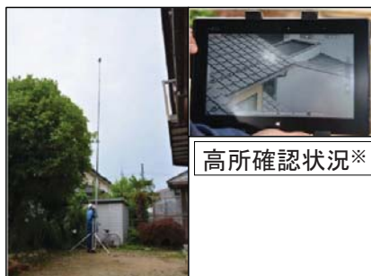
高所点検カメラ※
