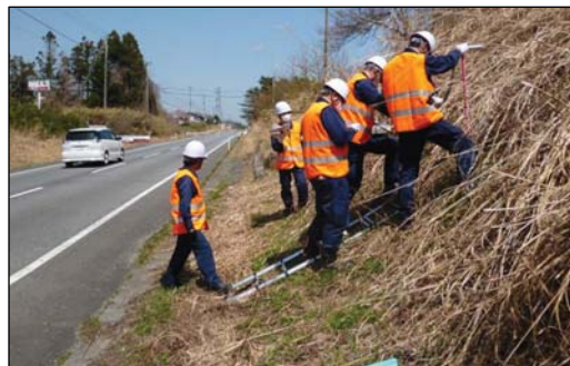
現場調査状況
