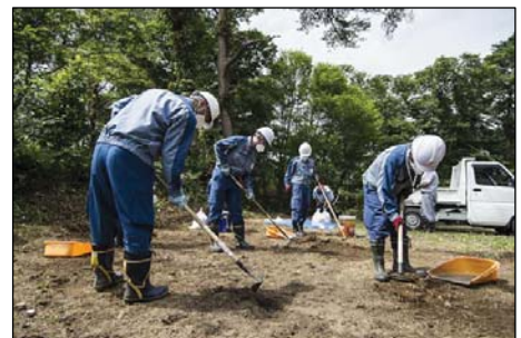
除染作業状況
