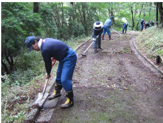
堆積土砂除去の様子[2015年9月11日撮影]
