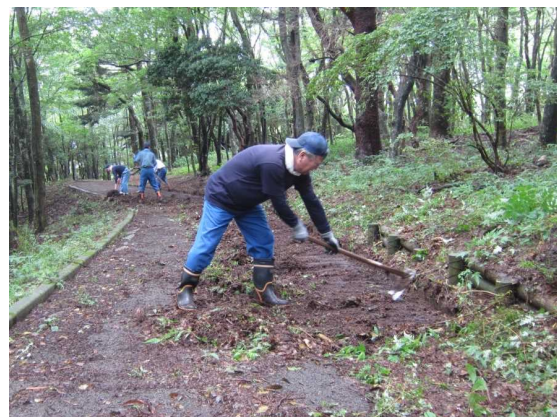
堆積土砂除去の様子[2015年9月11日撮影]
