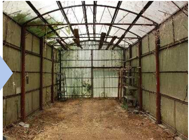
倉庫の搬出・片付け後の様子 [2016年6月8日撮影]
