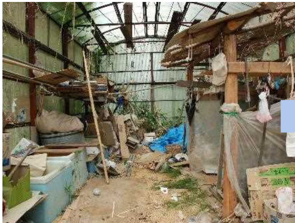
倉庫の搬出・片付け前の様子 [2016年6月8日撮影]
