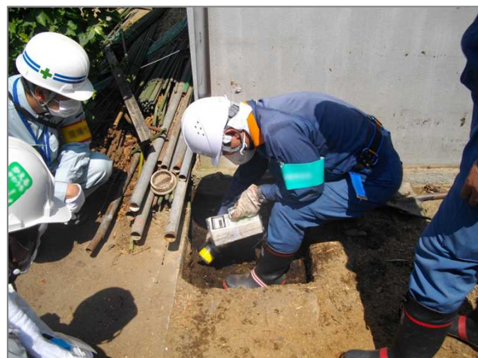
川内村 モニタリング状況（施工中）
