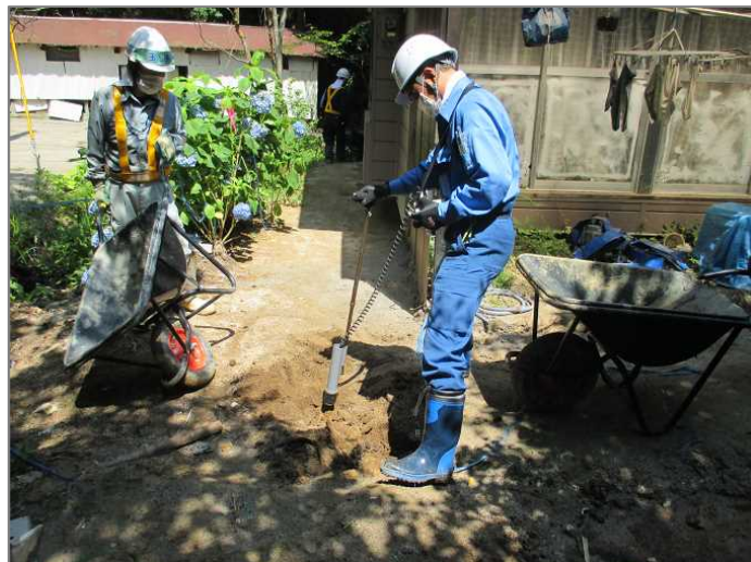
葛尾村 モニタリング状況（施工中）
