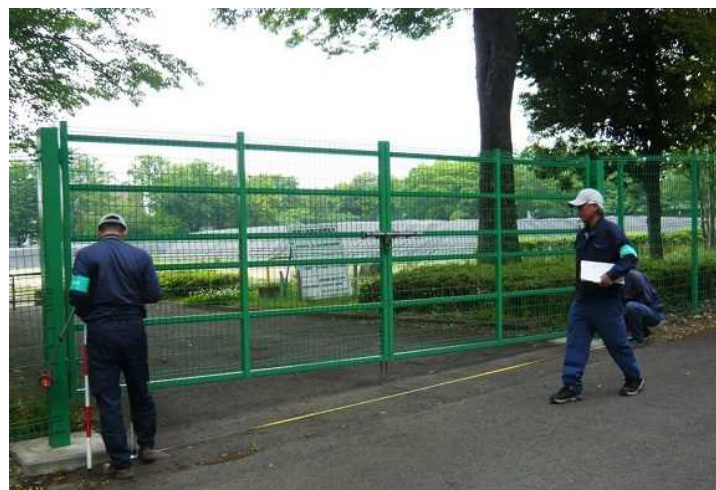
現場調査状況（仮置場入口の寸法確認）
