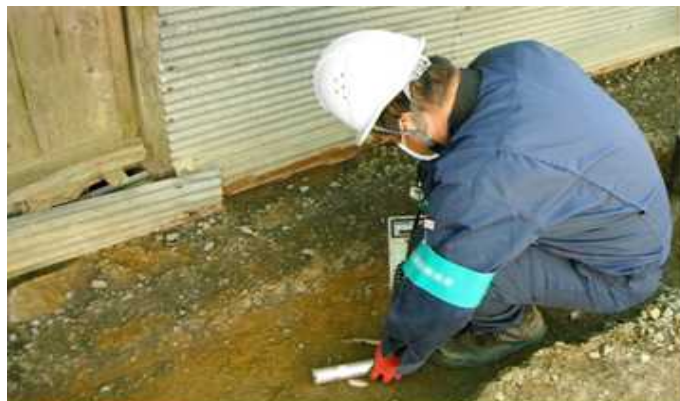
〔フォローアップ〕除染中の線量確認状況(2)
