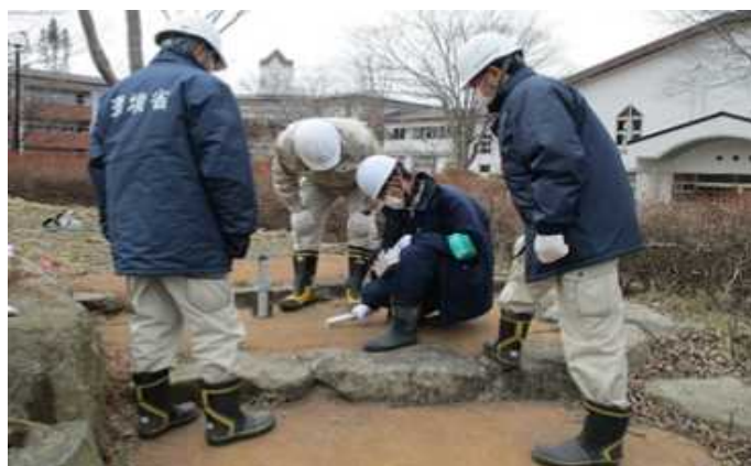
〔本格除染(学校施設)〕除染前の現地調査状況
