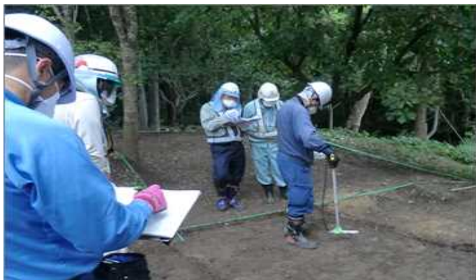
〔フォローアップ〕除染中の線量確認状況
