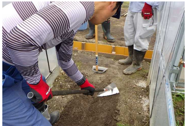
【側溝掘りの様子】(2019年6月27日)
