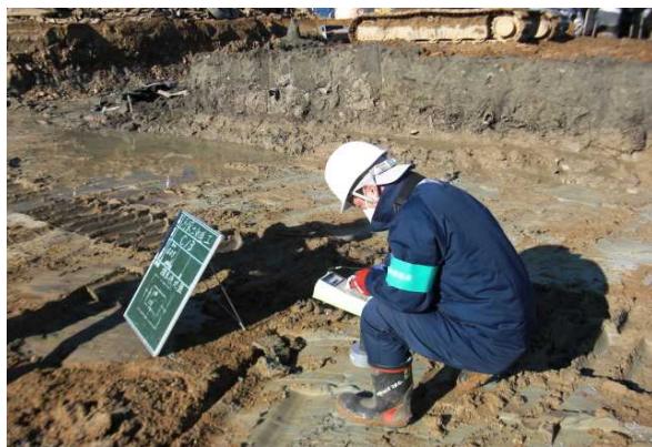
【埋め戻し前の線量確認状況】
