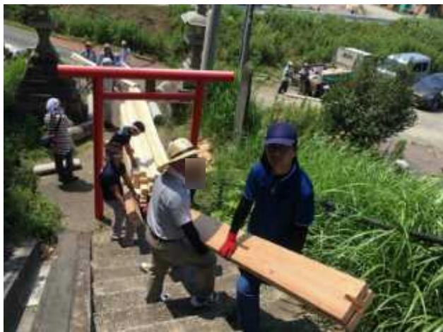
【木材荷揚げの様子】(2019年8月8日)
