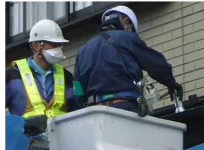
【現地調査状況（浪江町）】
