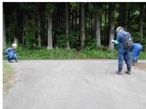
【輸送ルートの幅員測定状況】
