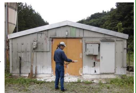
【モニタリング状況（鶏舎周辺）】
