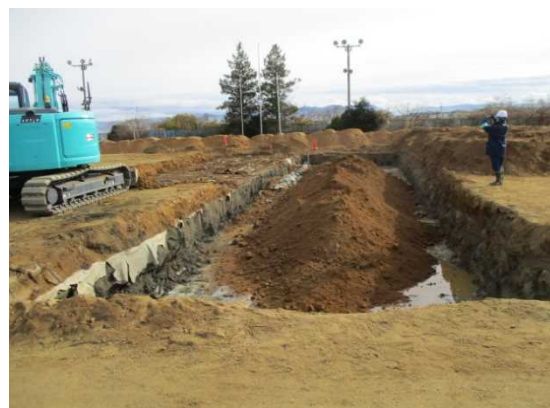
【埋め戻し中の確認状況】
