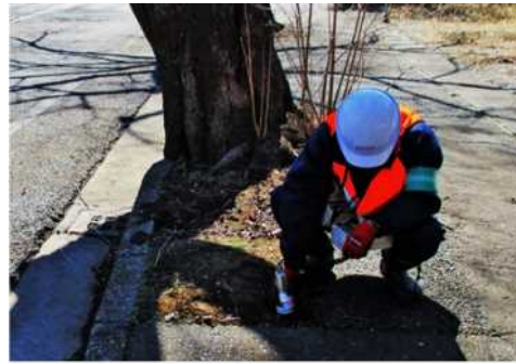
【本格除染後の線量確認状況(2)】
