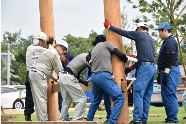
【櫓組立ての様子】(2019年8月9日)
