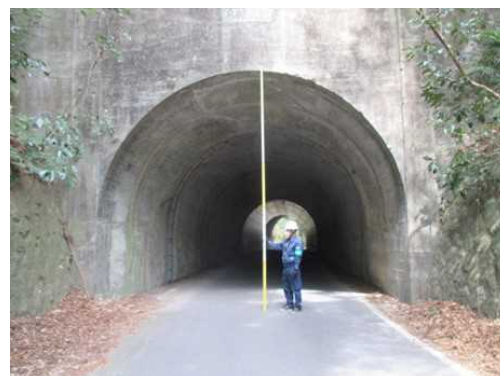
【輸送ルートの支障物高さ測定状況】
