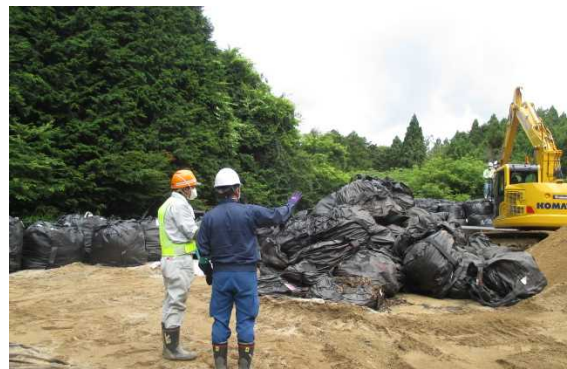
④保管容器の確認状況
