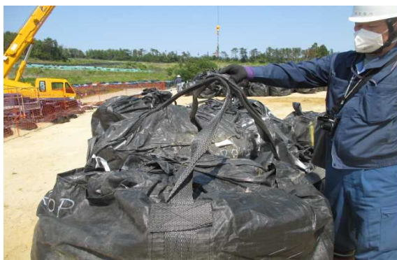
⑤吊りベルトの確認状況
