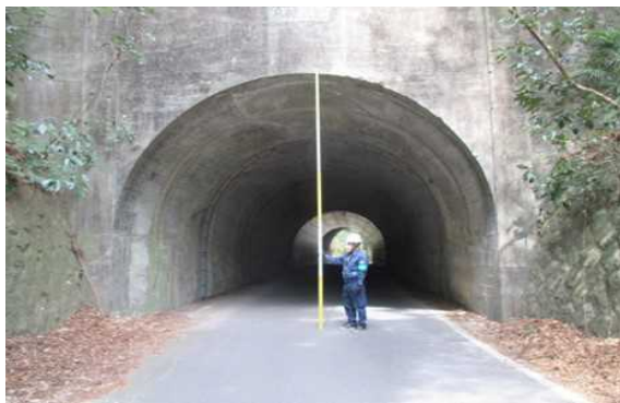
①輸送ルートのトンネル高さ測定状況
