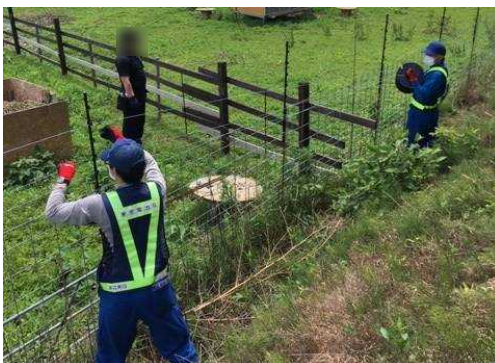
営農再開に伴う電気柵設置
