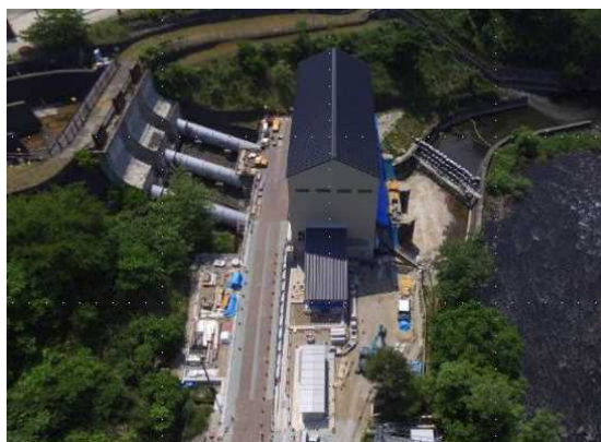
<改修後の発電所建屋>
