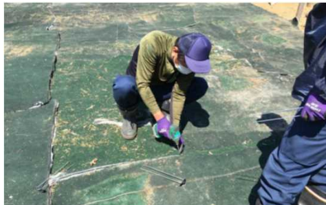
駐車場のシート張り
