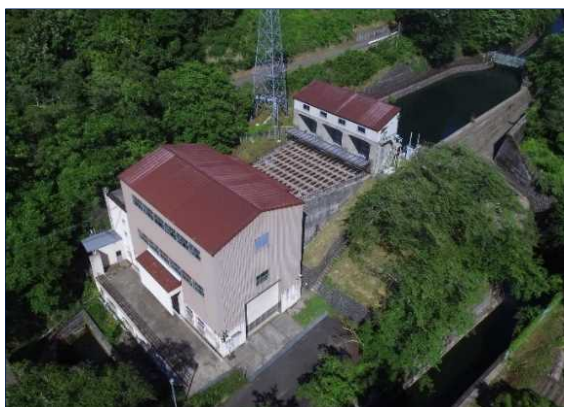
<既設の発電所建屋（工事なし）>
