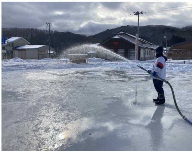
リンク整備の様子（夕方から水撒き）
