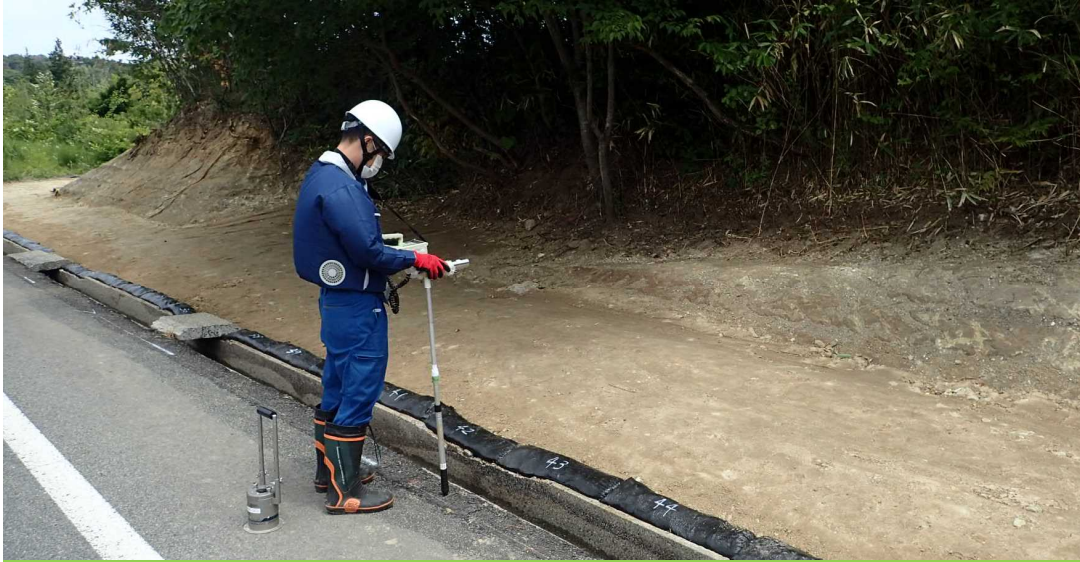
除染後の線量測定の様子【2021年6月】
