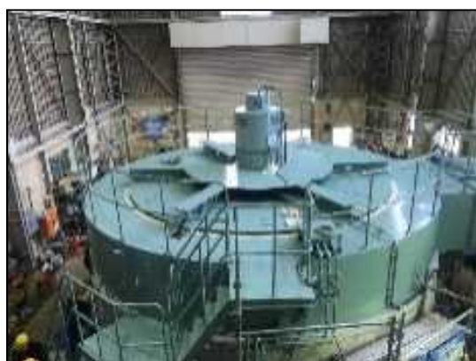
<改修後の発電機>
