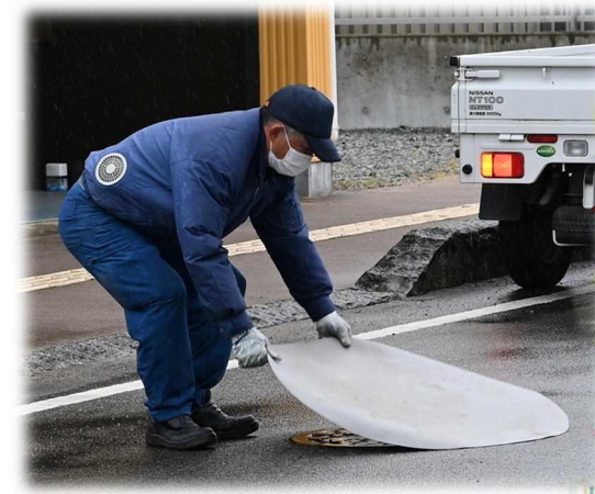
マンホールカバーの設置
