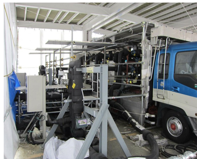
<常用高台炉注水ポンプ>
