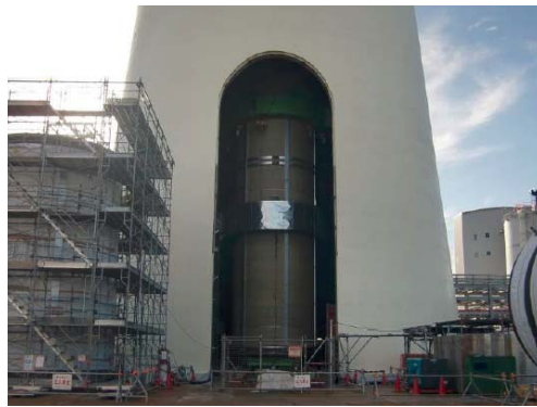
H22.9 煙突内筒新設工事
