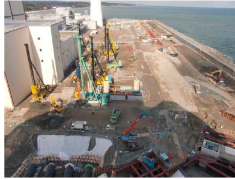
H21.11 ボイラー・タービン基礎地盤改良工事
