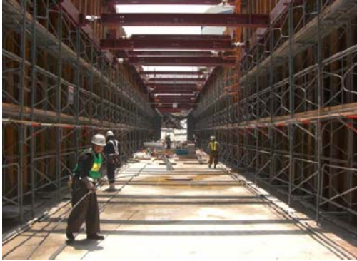
H21.5 復水器冷却水路 型枠・鉄筋工事
