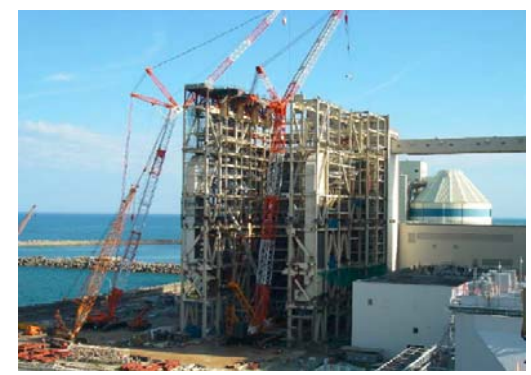
H23.8 ボイラー鉄骨建方(震災後工事再開)
