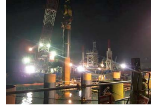
H22.6 第4バース杭打設工事(夜間工事)
