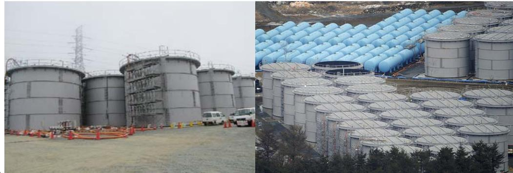
地下水バイパスは、山側から流れてきた地下水を、建屋の上流で揚水・バイパスすることで建屋内への地下水流入量を減らす取り組みです。最初のA系統の揚水井から汲み上げた地下水の水質確認、ならびにその水を貯蔵する一時貯留タンクの水質確認を実施しましたが、いずれも検出限界値未満または十分に低いことを確認しています。
