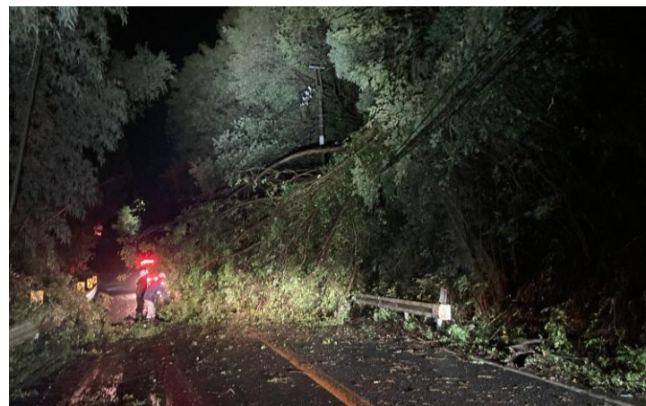
＜倒木の配電設備への接触＞
