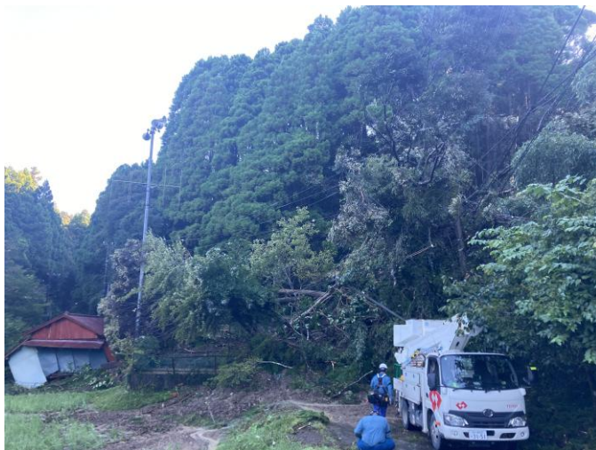
＜倒木による配電設備への接触・復旧作業＞
