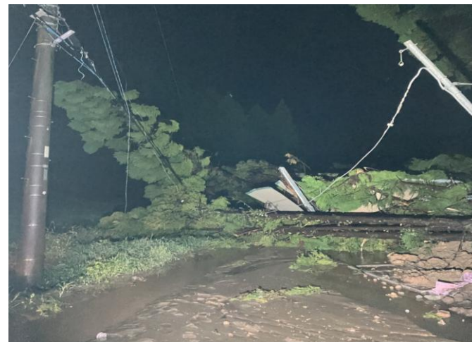
＜倒木による配電設備への接触・復旧作業＞
