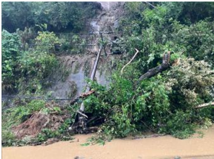
＜土砂崩れによる設備埋没＞
