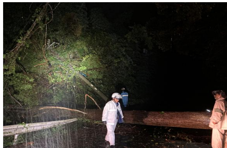
＜倒木による配電設備への接触・復旧作業＞
