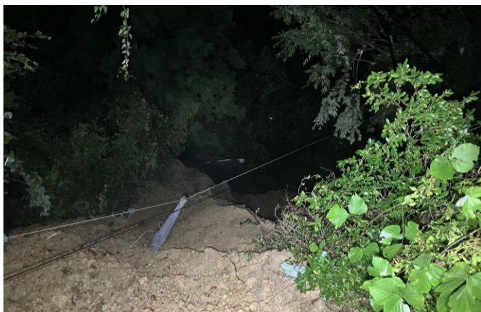
＜土砂崩れによる設備埋没＞
