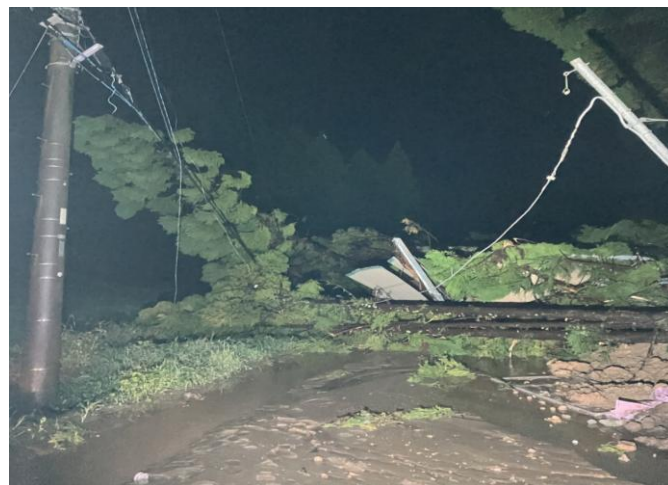
＜倒木による通行路寸断＞
