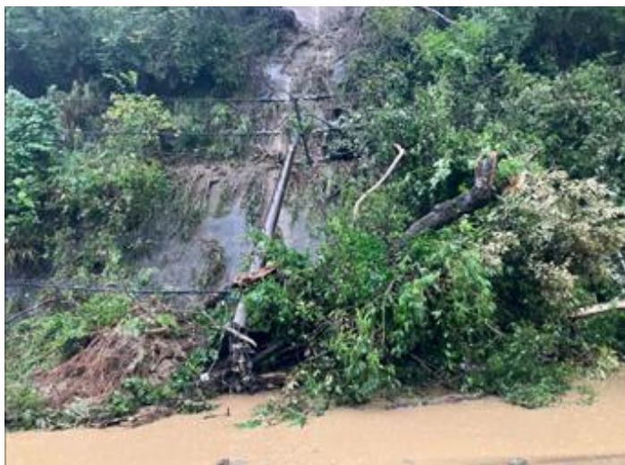
＜土砂崩れによる設備流出＞
