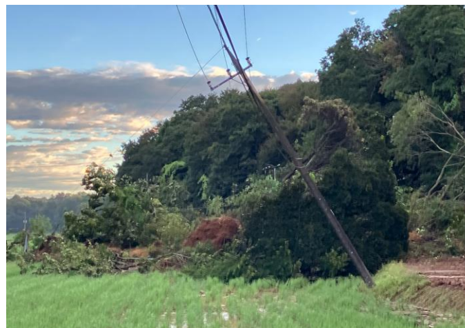
＜倒木による通行路寸断＞
