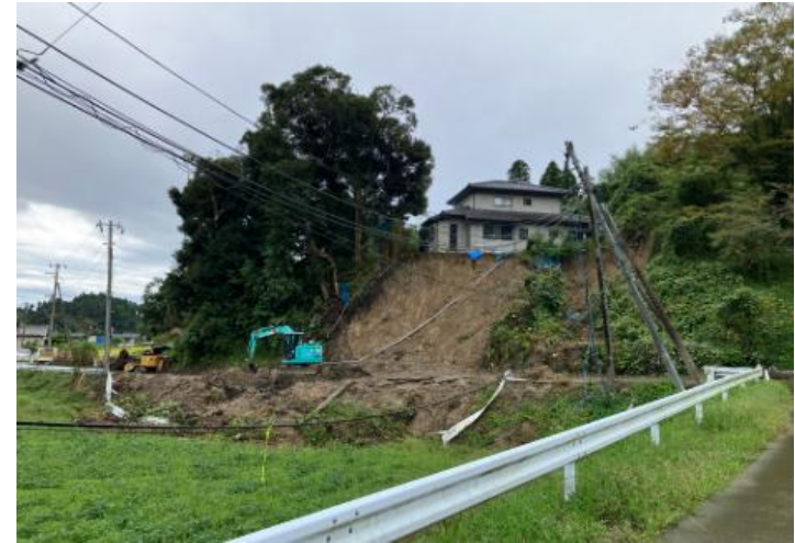
＜土砂崩れ箇所の作業＞
