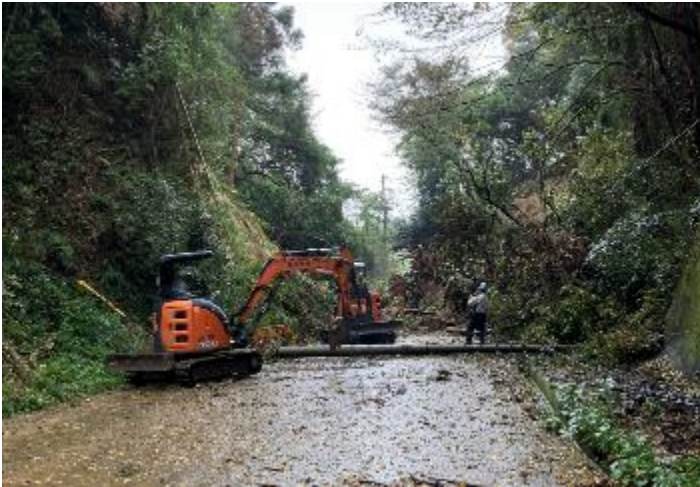
＜重機による道路啓開作業＞
