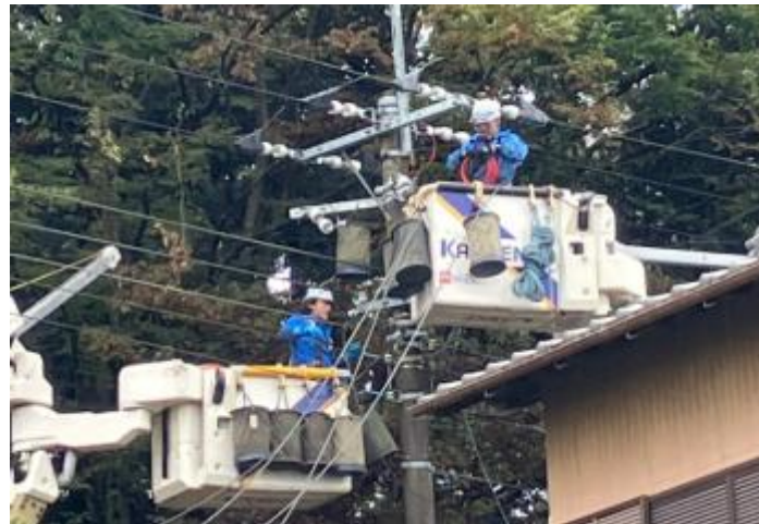
＜引込線改修工事＞
