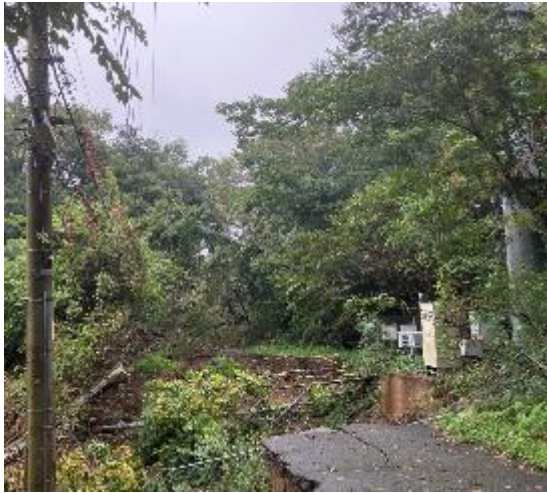
＜土砂崩れ箇所＞
