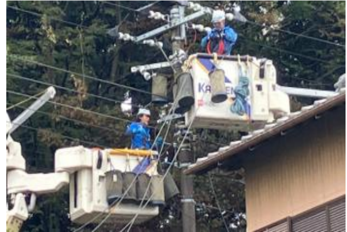
＜引込線改修工事＞
