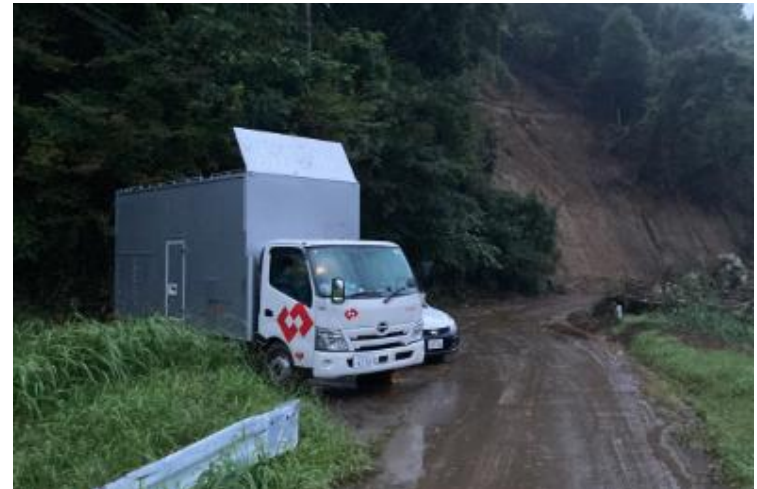
＜発電機車による応急送電作業＞
