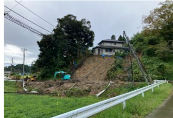
＜土砂崩れ箇所の作業＞
