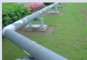
消火配管の地上化
