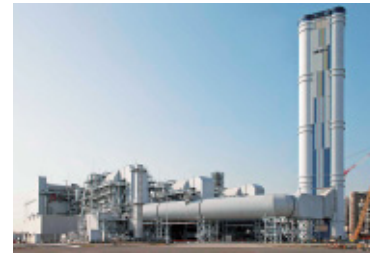
川崎火力発電所1号系列
