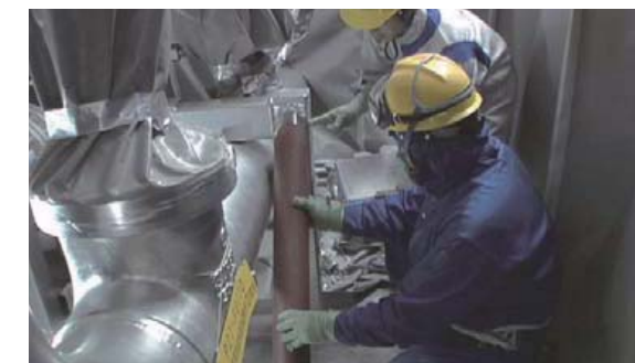
配管サポートの強化工事(7号機)
