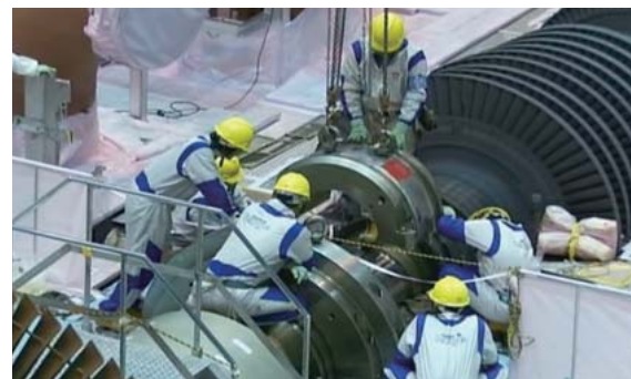
低圧タービン軸受の点検作業(7号機)
