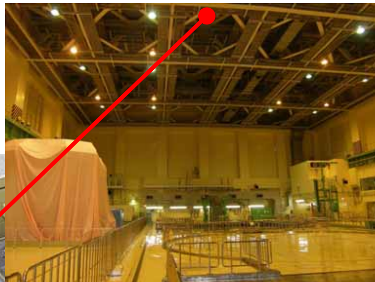
原子炉建屋 屋根トラスの強化
