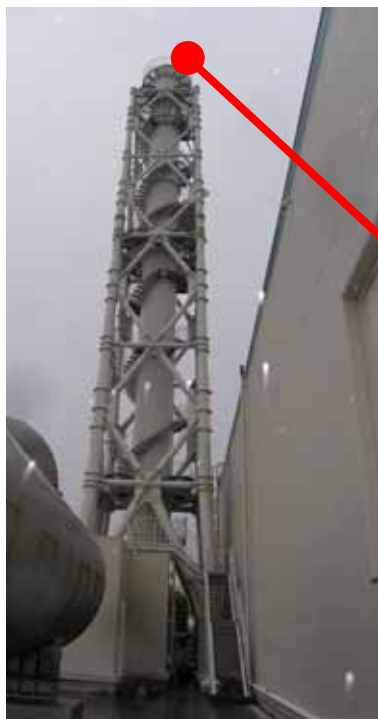
排気筒の支持 構造物の追設
